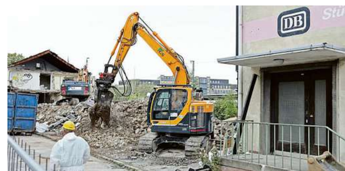
Bagger reißen am Hauptbahnhof ehemalige Gebäude der Deutschen Bahn AG ab. Foto: Christian Beier
