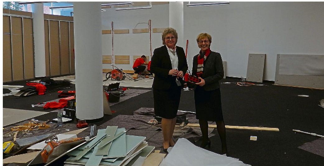
Die Niederlassungsleiterinnen der Commerzbank Münster, Heike Adamzik (l.) und Beate Simon, stellen ihre Baustelle in der ehemaligen Kundenhalle an der Königsstraße vor. Ende April ist die Neueröffnung geplant. Foto: gh
