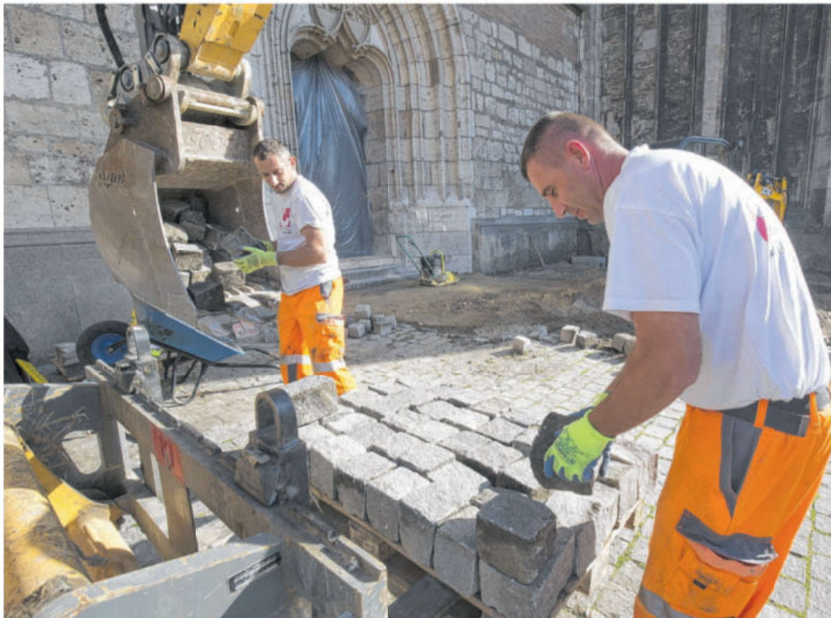
Bauarbeiter entfernen die Pflastersteine und die drei Stufen vor dem Eingang zum Nordschiff. Die Basaltquader werden später wieder verwendet und die Rampe bedecken. Foto: Oliver Schulz
